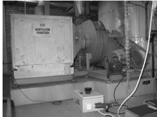
Rys. 11. Sposób badania częstotliwości rezonansowej konstrukcji posadowienia wentylatora
