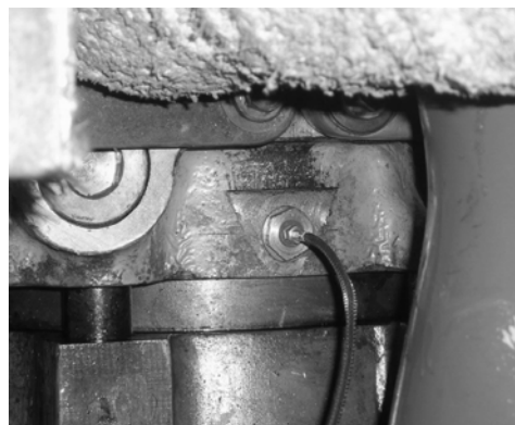
Rys. 3. Sposób zamontowania przetworników ciśnienia wewnątrzcyldrowego
