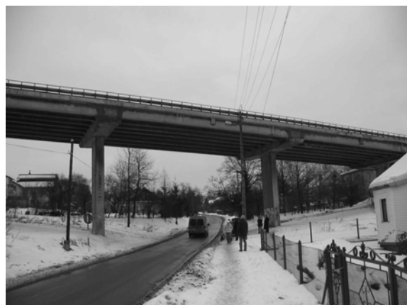
Rys. 1. Widok badanego wiaduktu
