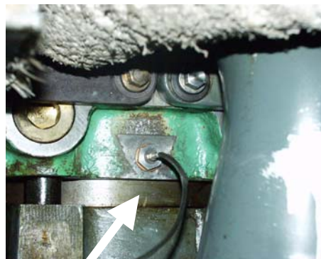
Rys.6.3. Miejsce zamontowania czujnika ciśnienia wewnątrzcyldrowego
